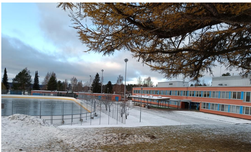
Kuva 4. Koulukeskuksen rakennuksia ja kaukalo
